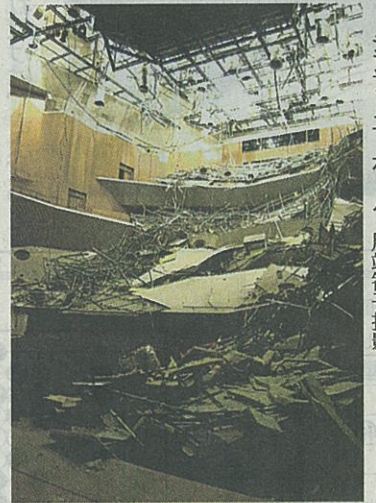
天井仕上げ材などが客席に崩落したミュンヘン・ミュンヘン・ミュンヘンホール。川崎端智子撮影
